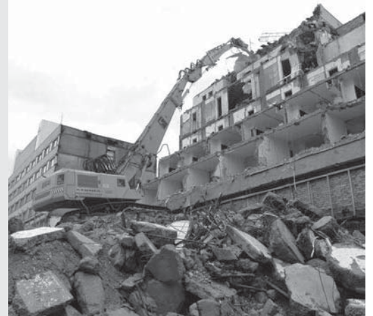
Een sloopschaar kan vliegtuigen en gebouwen stuk knippen.
