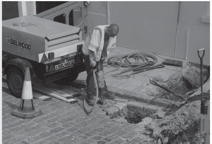
Bij een drillboor wordt lucht door een dikke slang geperst.
